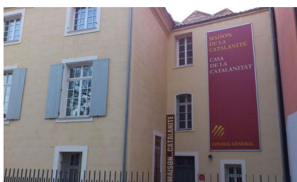
Maison de la Catalanité
